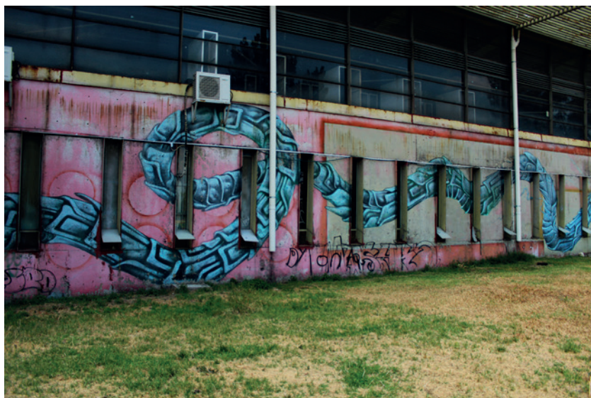
Imagen 25 Detalle del mural en nave principal, muro oriente extremo sur. Fotografía: Moisés Falcon, abril de 2023
