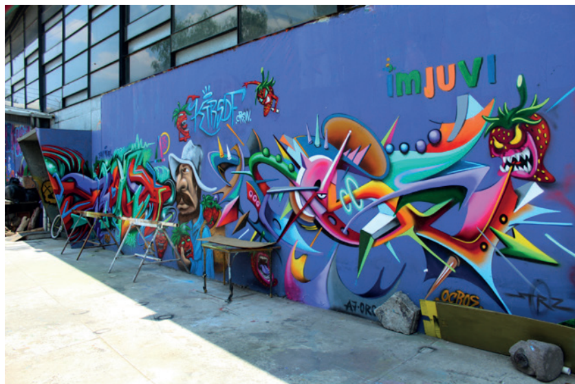
Imagen 33 Nave industrial, muro poniente 1. Fotografía: Moisés Falcon, abril de 2023
